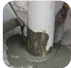
**Mortar Instan untuk pekerjaan pengisi celah anti susut dan perbaikan struktur beton, berbahan dasar semen, pasir, dan aditif yang memiliki daya kuat tekan tinggi, tidak susut serta memiliki *flowability* yang baik.**
